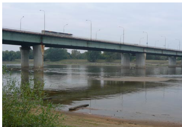
Fot. 1. Most Łazienkowski w Warszawie (fot. K. Karsznia)
