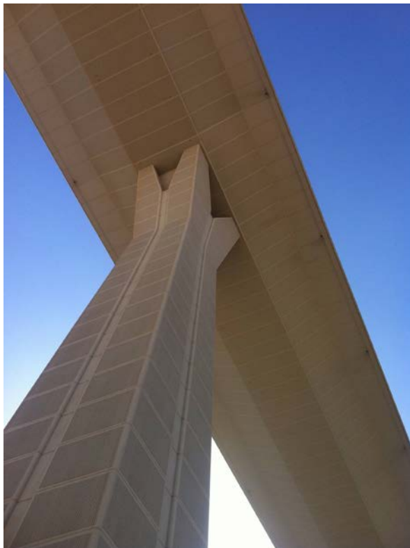
Widok konstrukcji mostu Wadi Leban w Rijadzie, na którym wdrożono system geomonitoringu
