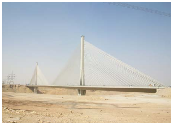
Widok mostu Wadi Leban w Rijadzie, na którym wdrożono system geomonitoringu
