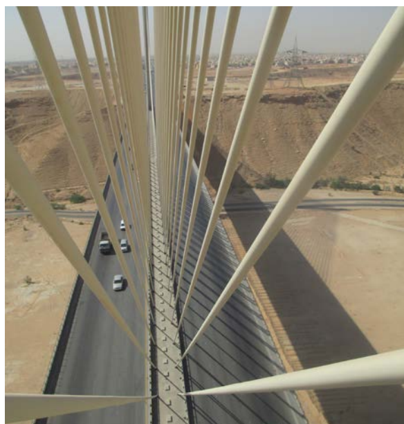
Widok konstrukcji mostu Wadi Leban w Rijadzie, na którym wdrożono system geomonitoringu
