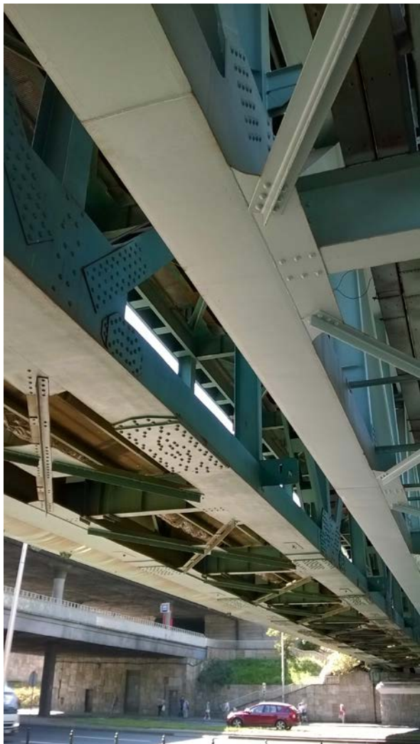
Widok konstrukcji Mostu Gdańskiego w Warszawie (fot. K. Karsznia)
